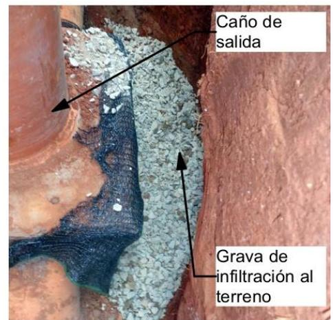
El registro de desagote se encuentra abierto en uno de sus lados y se cubre con una malla y un filtro de grava que permite la filtración del agua al terreno natural. Varios de estos registros se distribuyen a lo largo del sistema ICTA.
