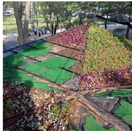
Fue construída una estructura de doble techo verde y aislación de muros fueron utilizados como sistemas complementarios de climatización pasiva.
