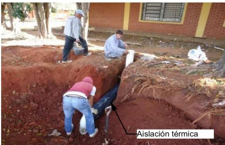
El tramo de cañería con salida a la superficie se aisló para evitar la ganancia de calor en la zona de contacto con la superficie del suelo.
