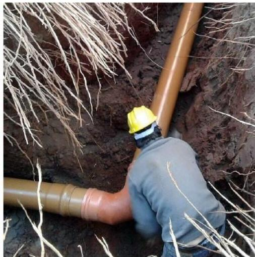
Luego de excavar el terreno hasta una profundidad promedio de 220 cm los ductos de aire fueron construidos y ensamblados in situ con caños de PVC.
