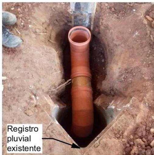
Para los puntos de entrada y salida del sistema se reutilizaron los registros pluviales existentes en el sitio.
