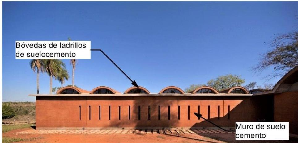
Fachada lateral de la casa Takuru. El muro de suelo cemento protege el pasillo de distribución de los dormitorios. Para el techo se construyeron bóvedas de ladrillos de suelocemento.
