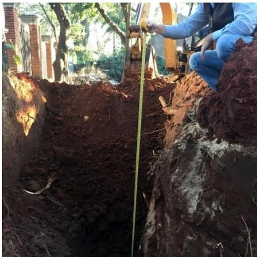
Medición de la profundidad de la zanja realizada con retroexcavadora. La cinta métrica marca 220 cm
