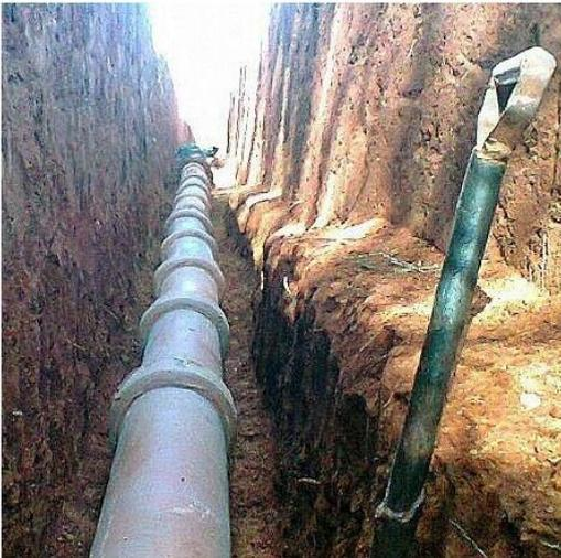
Los ductos de aire fueron contruídos con caños cerámicos organizados en distintos circuitos y asentados en el fondo de la zanja, a una profundidad de 2,50 metros y con una pendiente de 1% hacia el sector de registros de desagote.
