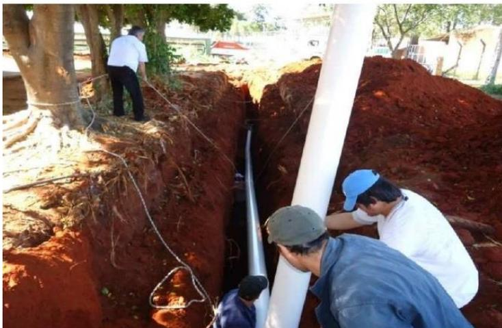
Se colocó el sistema de caños, previamente armado, en el fondo de la zanja. Los caños pre ensamblados fueron bajados cuidadosamente a la zanja con la ayuda de cuerdas.
