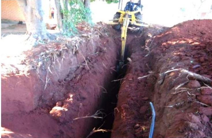
Luego de la planificación del trazado de los ductos, se realizó la excavación mecánica de la fosa con una zanjadora. Se realizó un escalonamiento en la excavación para evitar el desmoronamiento del suelo.
