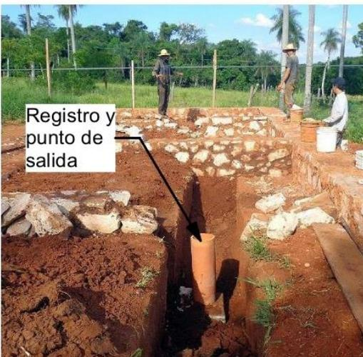
En los puntos de salida de aire se construyeron unos registros de salida y desagote. Estos puntos estaban ubicados en los ambientes principales de la vivienda: dormitorios y living comedor.
