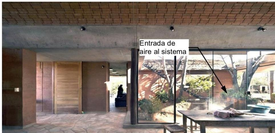
Interior del living-comedor. Un patio interior cubierto de vegetación alberga la entrada de los ductos del sistema ICTA. No existe un sistema de impulsión de aire en la entrada.
